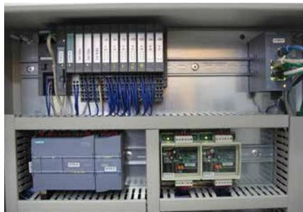
Feuchtemessung auf SPS-Basis; bis zu vier Messstellen ausbaufähig
